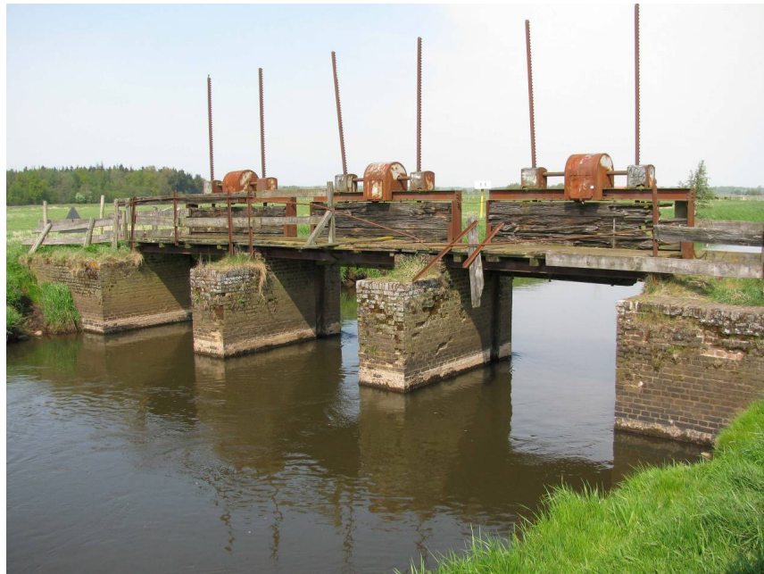
Abbildung 5: Wehr in der Stör an Station 52+700
