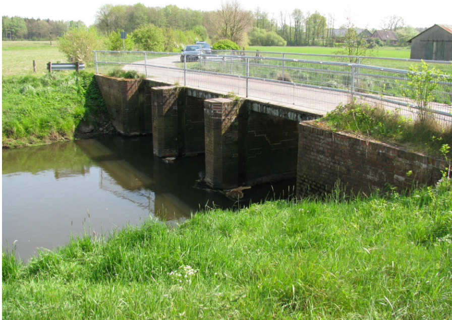
Abbildung 8: Wehr / Brücke an Station 55+100 in der Stör
