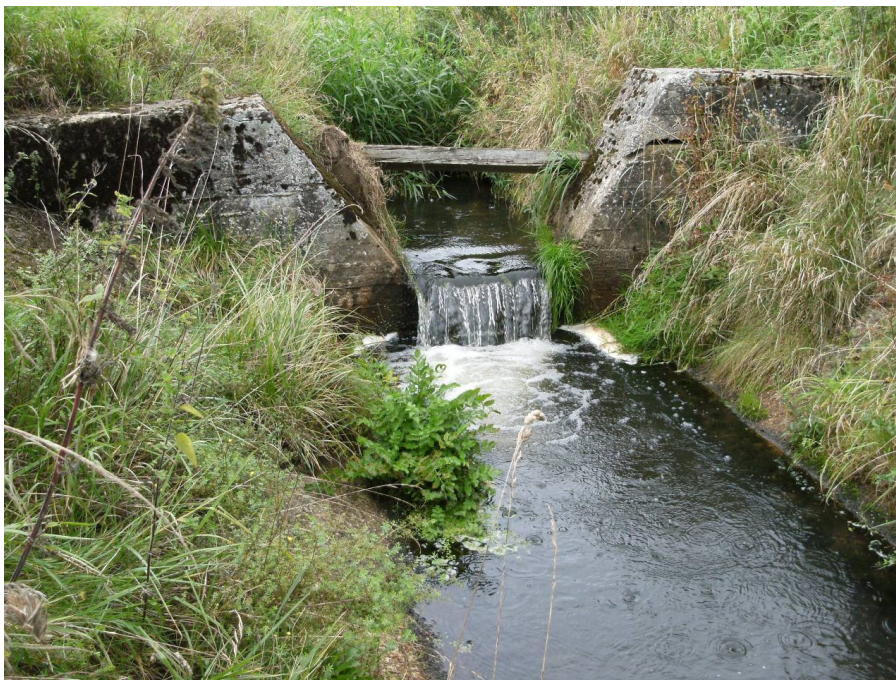
Abbildung 7: Abturm in der Wegebek an Station 4+475
