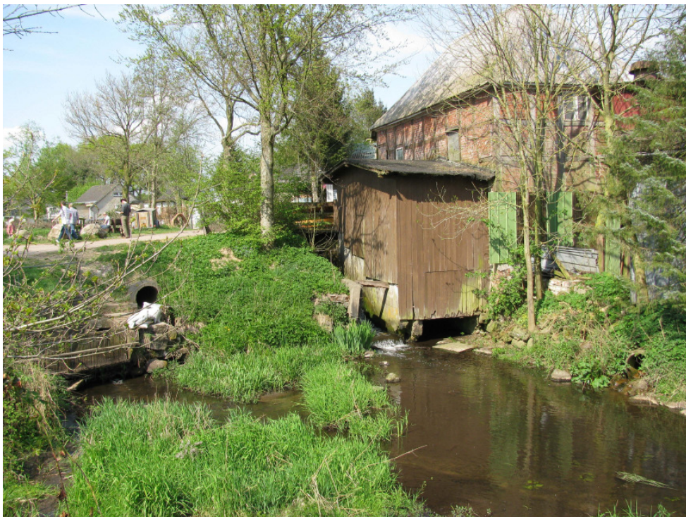
Abbildung 9: Mühlenbauwerk/Wasserkraftanlage und Wegebek unterhalb Mühlenteich
