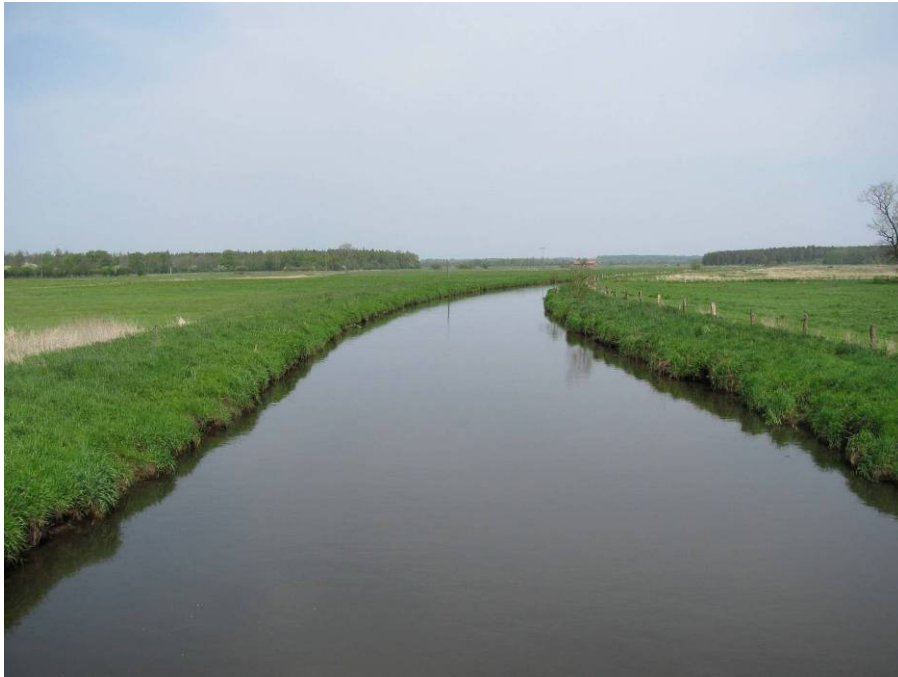
Abbildung 2: Beispiel der Verwallung an der Stör an Station 49+900
